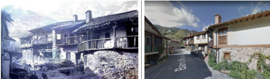
Una de las imágenes antiguas más conocidas de Mogrovejo, en comparación con el estado actual de las edificaciones que en ella aparecen, viendo cómo se ha desfigurado completamente el conjunto.
