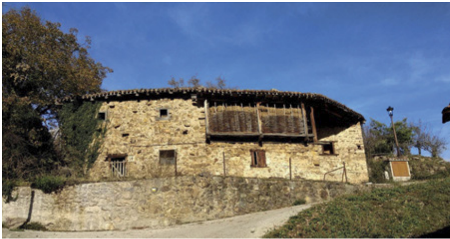
Edificación de cuadra-pajar de importantes dimensiones, con las características de las edificaciones agropecuarias tradicionales, incluyendo una destacada pieza de madera con cerramiento de sieto en la planta alta.
