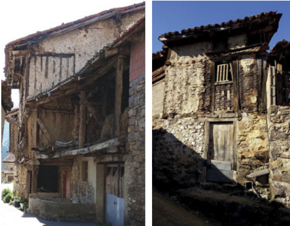
Cerramiento con adobe, madera y entreverado de avellano, en las dos viviendas lebaniegas localizadas en Mogrovejo.
