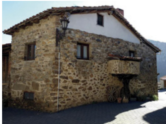
Vanos sin recercar en edificación agropecuaria (izq.) y en vivienda (dcha.)
