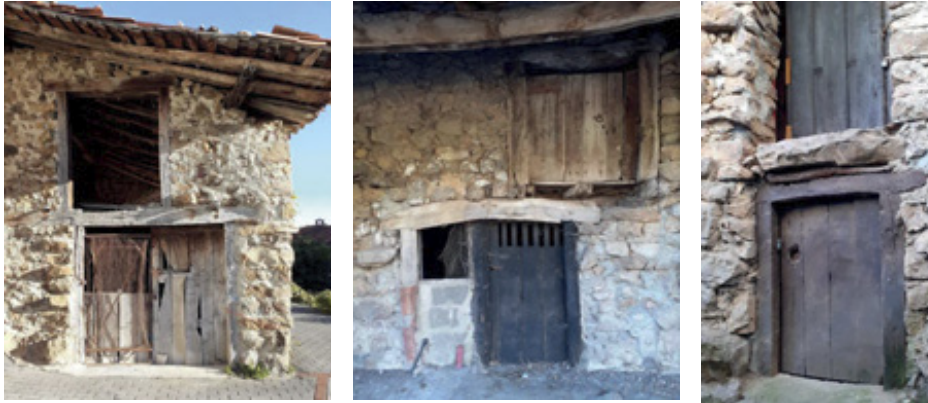
Ejemplos de vanos abiertos mediante elementos de madera en edificios agropecuarios
