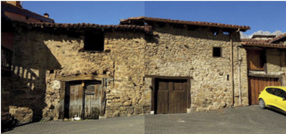
Ejemplo de huecos en edificios agropecuarios, con la misma sistemática: hueco en planta baja de mayor dimensión (en este caso, en formato casi cuadrado), y hueco en planta alta más pequeño (en estos dos casos, más pequeños de lo habitual, que suele ser un tamaño como el de la derecha).
