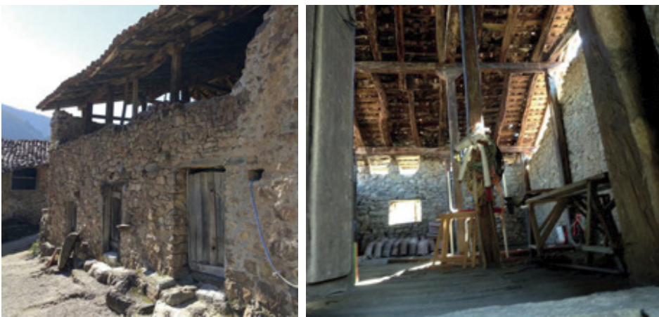
Ejemplos de estructuras de madera en plantas altas de edificaciones agropecuarias, dejando los muros de mampostería como mero elemento de cierre, sin función portante. Se observa cómo no llegan hasta la cubierta, permitiendo aireación.
