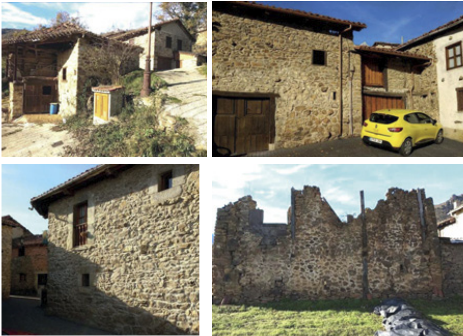
Cerramientos de mampostería, tanto en edificaciones residenciales como agropecuarias.
