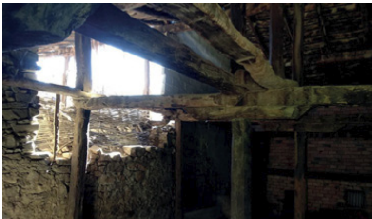
Vista desde el interior de un “hueco de sieto”, en el lateral de una edificación agropecuaria
