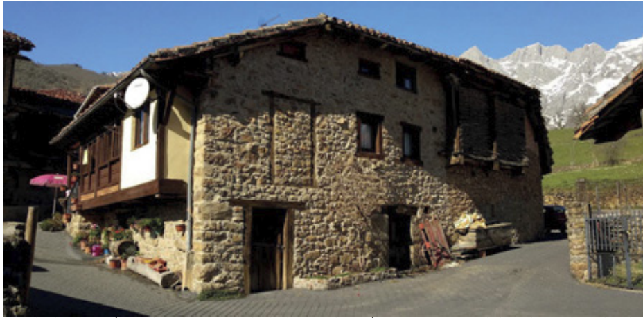
Ejemplo de edificación residencial transformada desde una edificación agropecuaria (con balconada), en la cual se han cegado o reutilizado los huecos agropecuarios, y se han añadido otros huecos, debido al cambio de uso a vivienda, por lo que pueden apreciarse ambos tipos de huecos simultáneamente.
