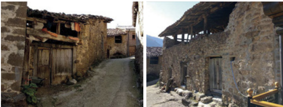
Vistas de anexos agropecuarios con esa característica de muro de mampostería con parte superior libre.
