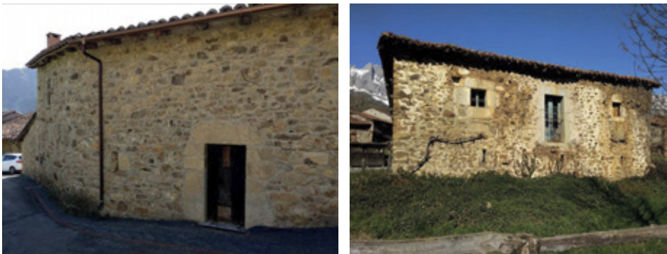
Vanos de viviendas singulares enmarcados con sillares de piedra no labrada
