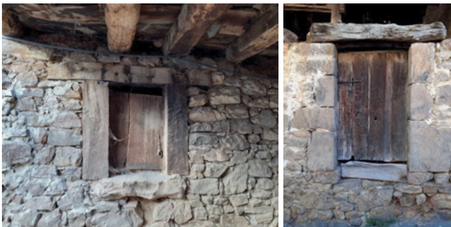
Ejemplos de formalización "mixta" de huecos, con una parte realizada en madera (jambas y dintel a la izquierda, dintel a la derecha) y el resto del hueco formalizado con sillares de piedra (tosco a la izquierda, para hacer el alfeizar, labrados a la derecha como jambas).
