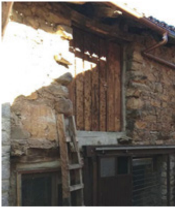
Vanos sin recercar en edificación agropecuaria (izq.) y en vivienda (dcha.)
