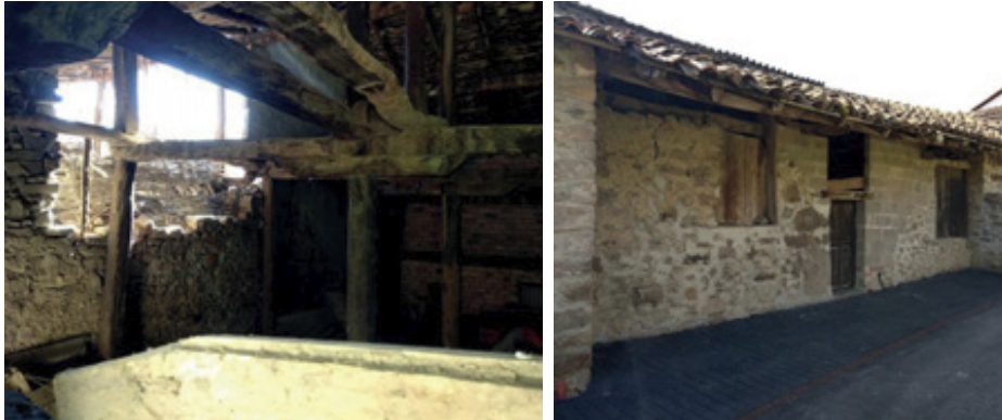
Vista interior y exterior de un anexo agropecuario habitual, con una planta un altillo, y cierre de sieto en una pared.
